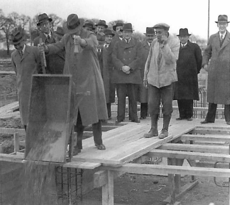
Dr. ir. D.P. Ross Van Lennep leegt een kruiwagen beton als gedenkwaardig startpunt voor de bouw van het Centraal Laboratorium in 1939.
